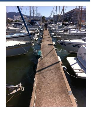
Construcciones Metálicas Ferrer, ha diseñado, y construido 96ml de pantalán de aluminio fijo Unideck® de 12x1,2m. Se han instalado pues, 8 tramos de pantalanes, pasando a disponer de un ancho útil de 1,2m respecto a los 0,9m existentes. De esta manera la Comunidad de Propietarios se ha puesto al día y ha actualizado su instal·lación.
